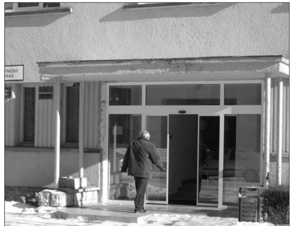
Nový, bezbariérový vstup do budovy, kde sídli Mestský úrad Svit. Foto: M. Jurčák
