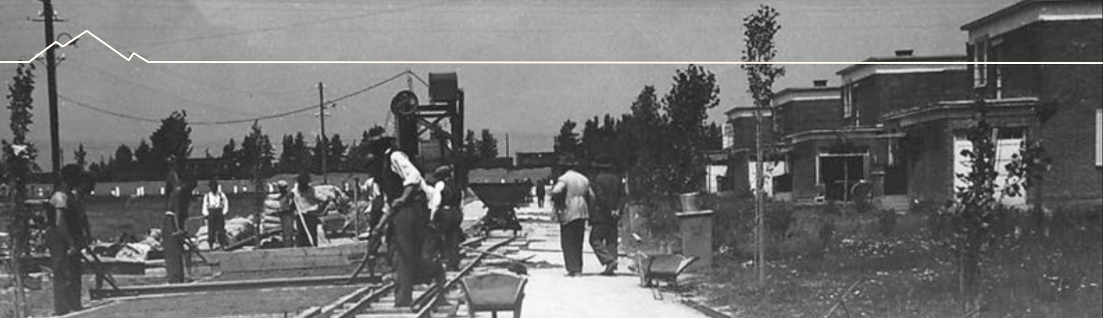
Betonáž cesty od štátnej hradskej do priemyselnej a bytovej zóny (rok 1936)
