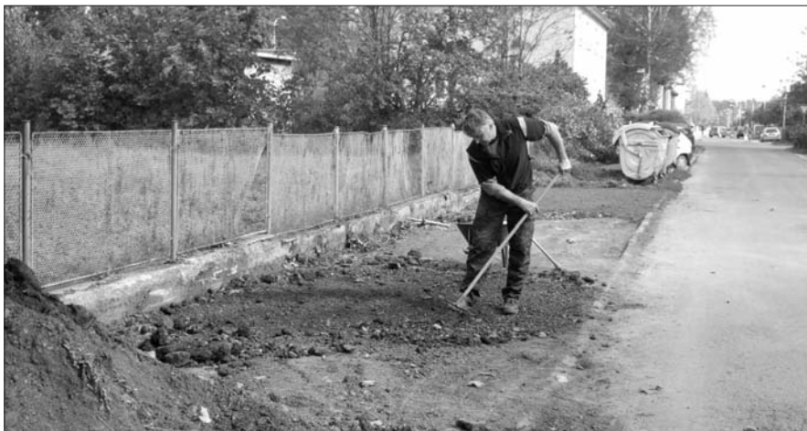
Ešte pred zimou je dobré upraviť si okolie svojich domov - v tomto prípade na obr. úprava priestoru na parkovanie áut na Ul. kpt. Nálepku.
